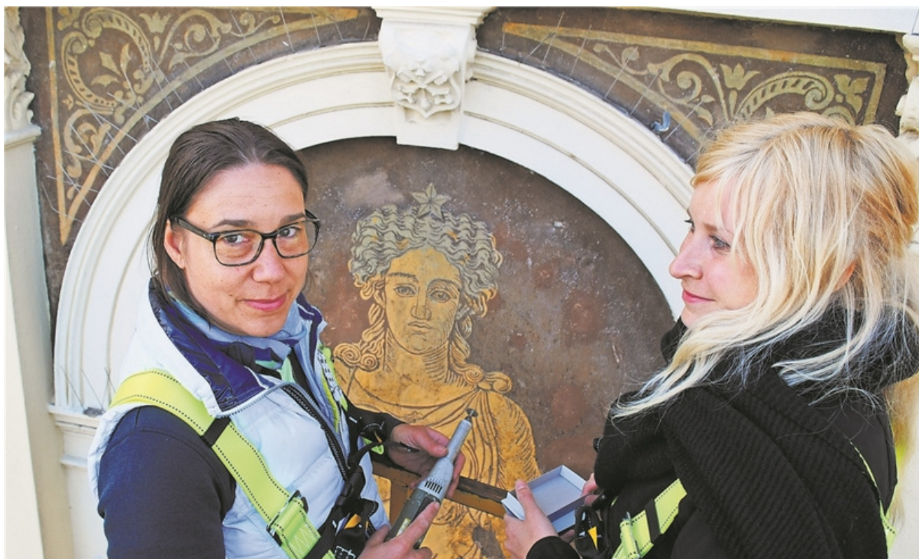
Die Restauratorinnen Christiane Maier und Ina Heine (rechts) nehmen an der Ruhmes-Allegorie am linken Flügel des Hauptgebäudes der Hochschule 21 eine Probe. Sie wollen die Sgraffiti, das ist eine Kratzputz-Technik aus dem 15./19. Jahrhundert, restaurieren und zum Teil rekonstruieren. Fotos Vasel
