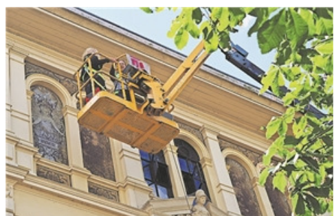
Arbeitsplatz in luftiger Höhe: Mit dem Hubsteiger fahren Christiane Maier und Ina Heine nach oben.
