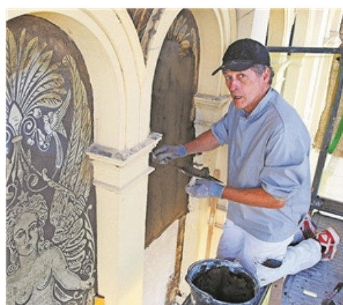
Vorbereitung: Stuckateur-Meister Immo Linsen bringt den für Buxtehude entwickelten Putz auf; links ist die 2002 restaurierte Allegorie „Handwerk“ zu sehen.
