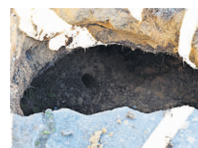
Das Loch ist nur etwa 50 Zentimeter breit, aber darunter liegt eine ausgespülte Höhle von mehr als einem Kubikmeter.
