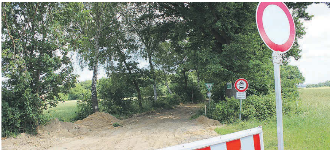
In Dollern wird derzeit der unter Denkmalschutz stehende Heuweg saniert
