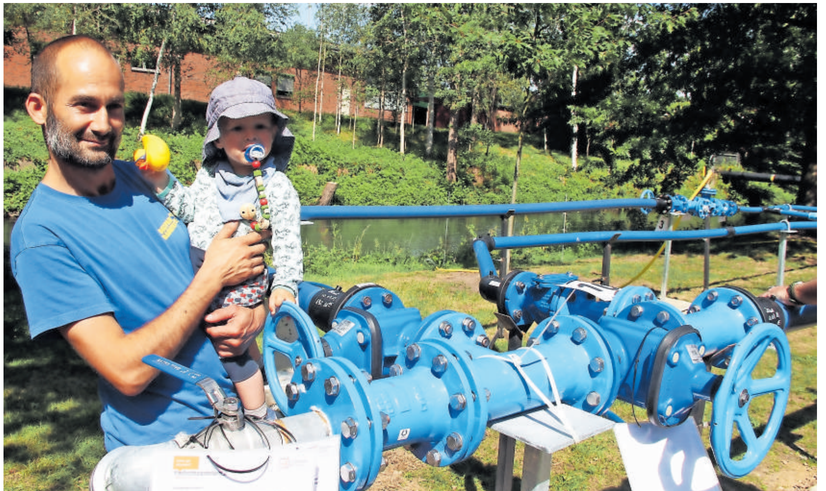
Auch das Wasser ist natürlich immer ein Thema bei den Stadtwerken: Für die Besucher hatten die Stadtwerke mal oberirdisch aufgebaut, was sonst unter der Erde liegt: eine Wasserleitung von der Hauptleitung bis zum Hausanschluss. Amir Abbassian und sein Sohn Anton (1) aus Buxtehude schauen sich die imposanten blauen Schieber an, mit denen sich das Wasser im Notfall ab- und anstellen lässt.
