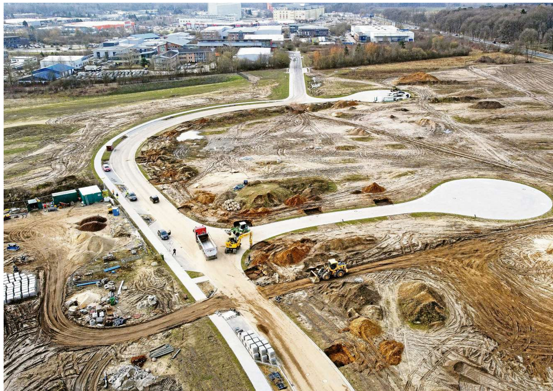
Am Buchholzer Stadtrand entsteht das 5G-Testfeld im Innovationspark Nordheide. Die Aufnahme zeigt die Baustelle im Februar 2021.
