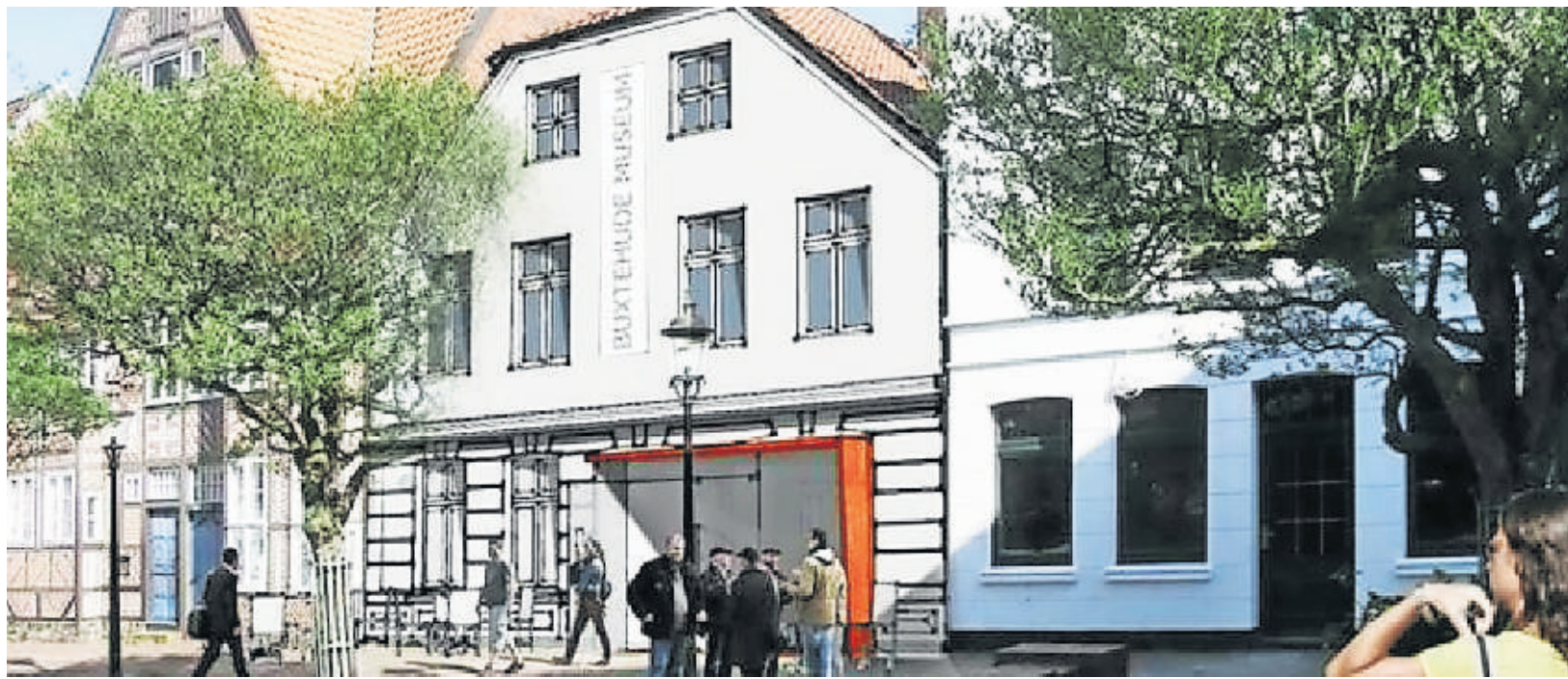
So wird der Eingang des Buxtehuder Museums aussehen: Im Bereich des heutigen Schaufensters entsteht im Samel-Haus der großzügige Haupteingang mit einem Cortenstahl-Element – eine architektonische Einladung zu einer Zeitreise durch die Stadtgeschichte. Links ist der Altbau des Museums.
