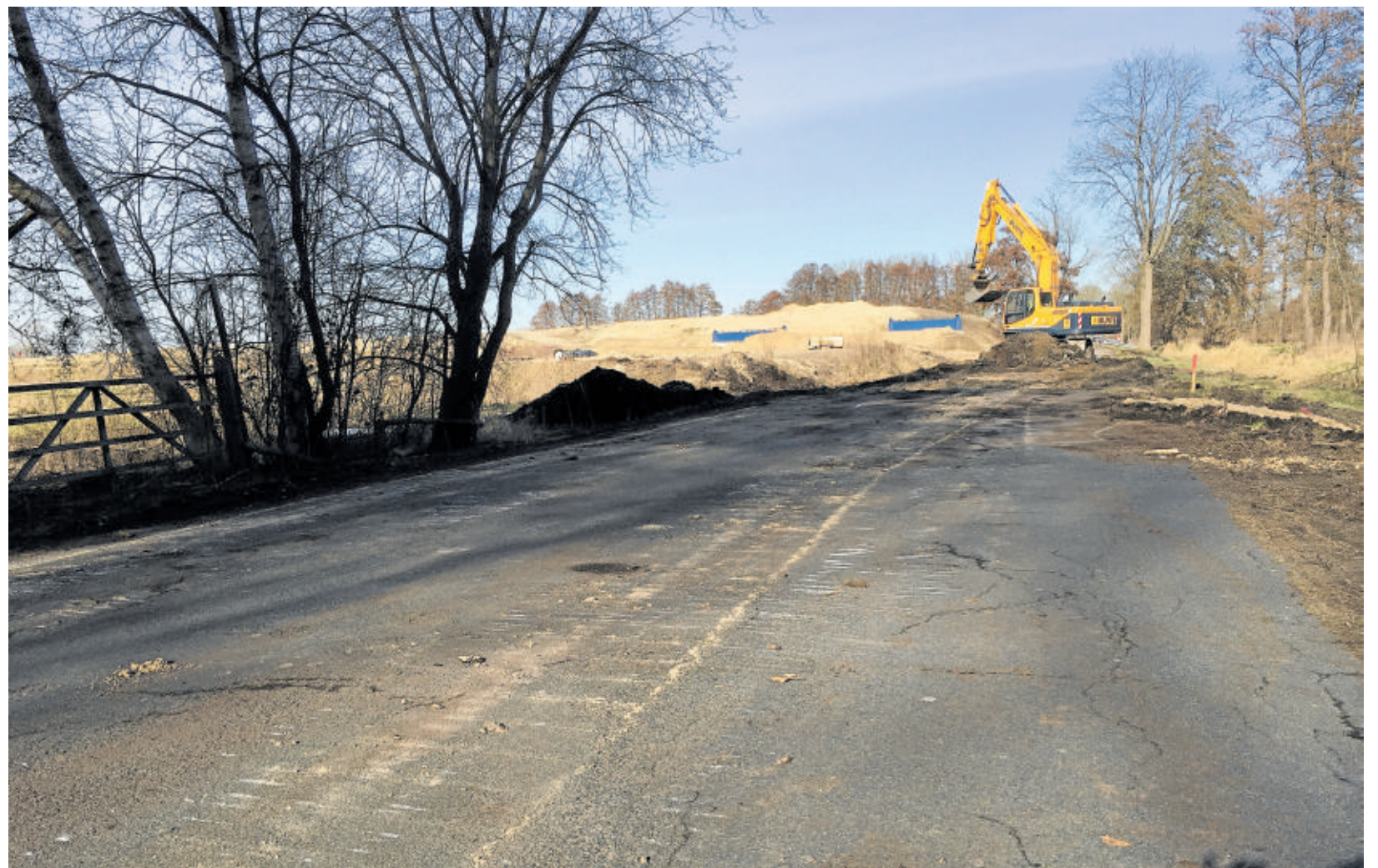
Die Bauarbeiten an der Rübker Straße laufen bereits. Gerade wird die Straße umgelegt.
