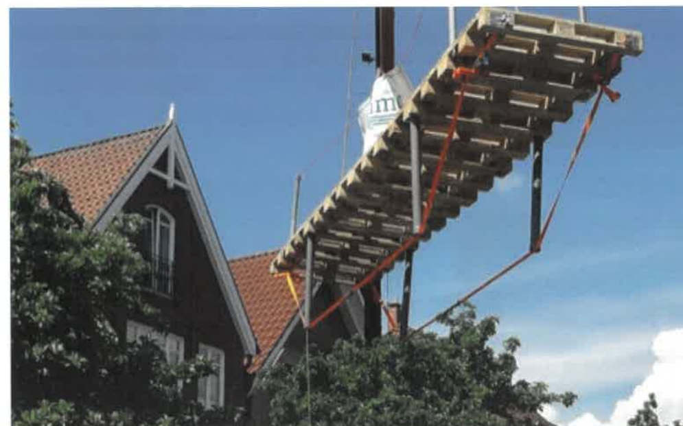
Einheben der Brücke
