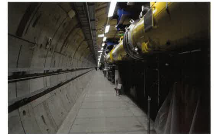
Abb. 2 Tunnel des XFEL im Original
