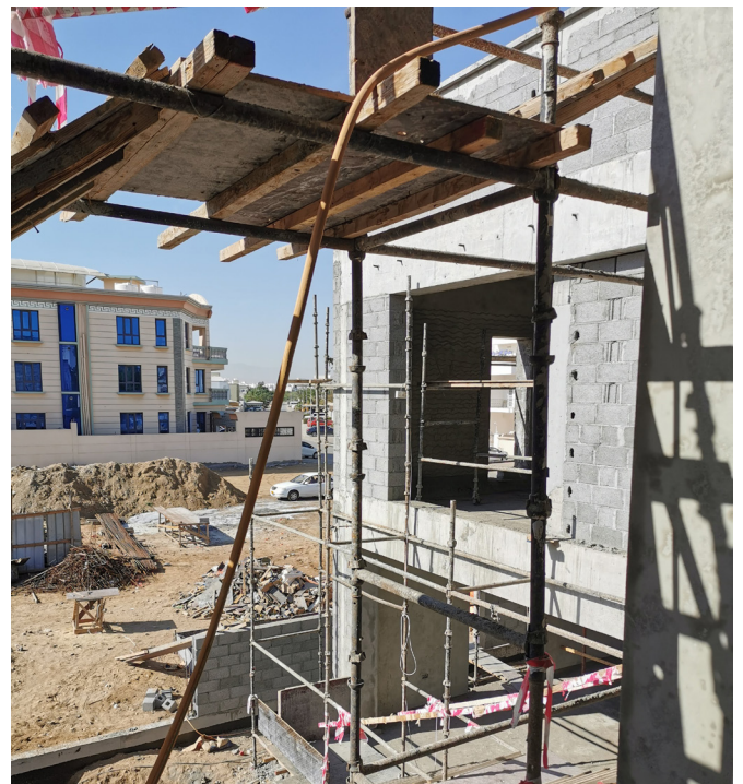
Blick auf die Baustelle eines Einfamilienhauses im Rohbau
