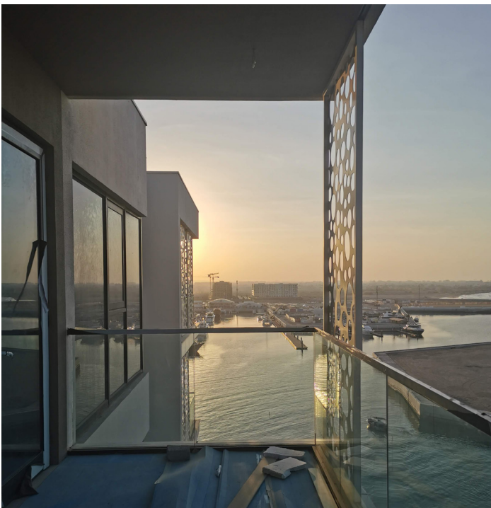
Blick auf die Marina von Al Mouj in Maskat von der Baustelle eines Innenausbaus des Staffelgeschosses
