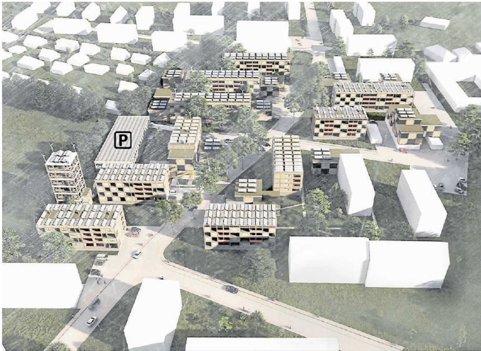
So könnte das Quartier aussehen, wenn es dem Standard „Effizienzhaus Plus“ entspräche: Photovoltaik- und kleine Windkraft-Anlagen auf den Dächern, ein Hubspeicher (der Turm ganz links im Bild) für die überschüssige Energie. Außerdem soll ein Parkhaus für Wasserstoff-Fahrzeuge entstehen. Visualisierung: Hochschule 21
